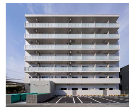
FREEDOM residence 深井沢町 (2025年3月完成)
